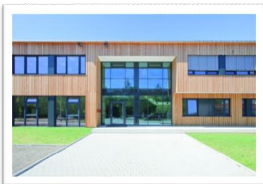
Juni 2013: Der Kienzle-Bau ist fertiggestellt
